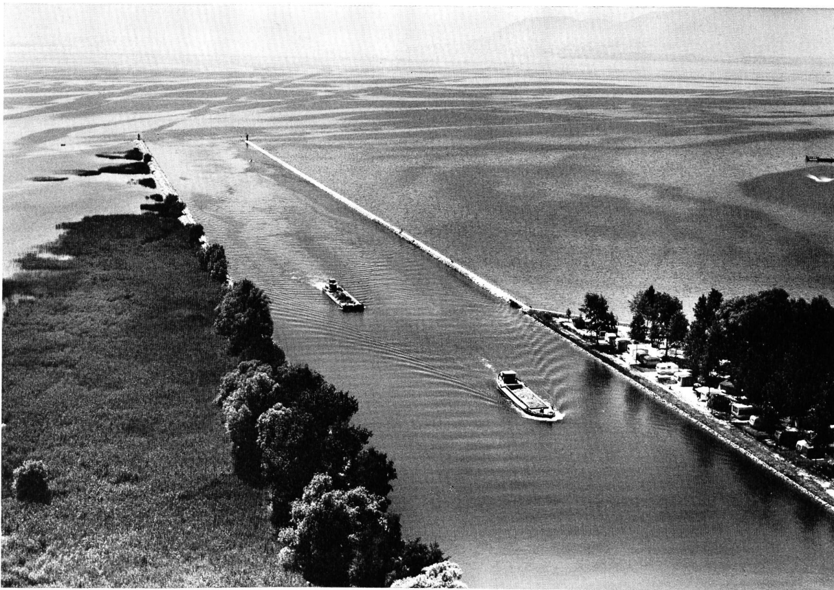
Der neue Einlauf des Zihlkanals im Neuenburgersee (Photo Comet, Zürich)
