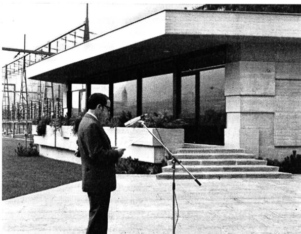
Bild 1 Direktor M. W. Rickenbach begrüsst die zahlreichen Gäste der Kraftwerke Brusio AG; im Hintergrund die neue Kommandozentrale und Freiluft-Schaltanlage beim Kraftwerk Robbia
