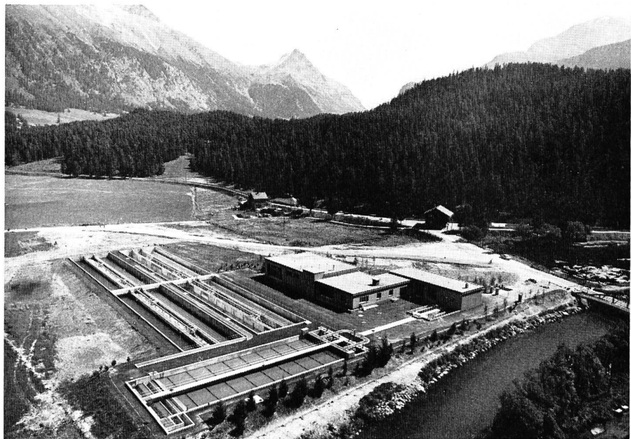
Bild 1 Gesamtübersicht der ARA Staz; im Vordergrund hart am Innufer Vorklärbecken I und II, dahinter biologische Anlage mit den Becken I bis IV, rechts Rechenanlage, Betriebs- gebäude und Schlamm- behandlungstrakt. Im Hinter- grund Stazerwald und Piz Albris
