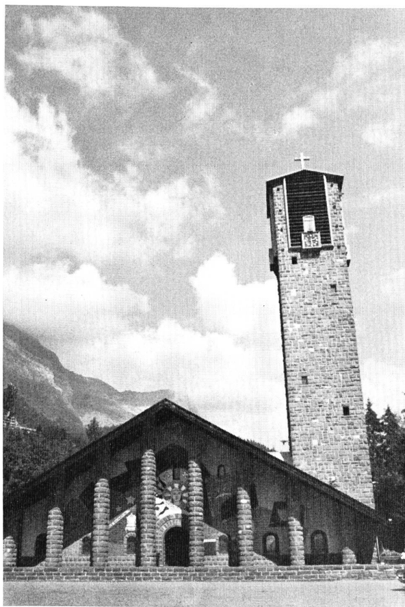
Bild 1 Hauptfassade und Turm der modernen Kirche Notre-Dame de Toute Grâce auf dem sonnigen Plateau d'Assy am rechten Talhang hoch über der Arve.
