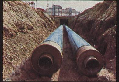
Das gilt nicht nur für den Raumanzug des Astronauten, sondern auch für viele Dinge auf unserem Planeten. Zum Beispiel für Fernwärmeleitungen. Dafür liefern wir den sicheren Schutz – Mantelrohre aus Stahl. Das feste und zugleich elastische Stahlrohr lässt sich an den Verbindungsstellen absolut dicht miteinander verschweißen. Es fängt Erdbewegungen und Verkehrslasten sicher ab.
