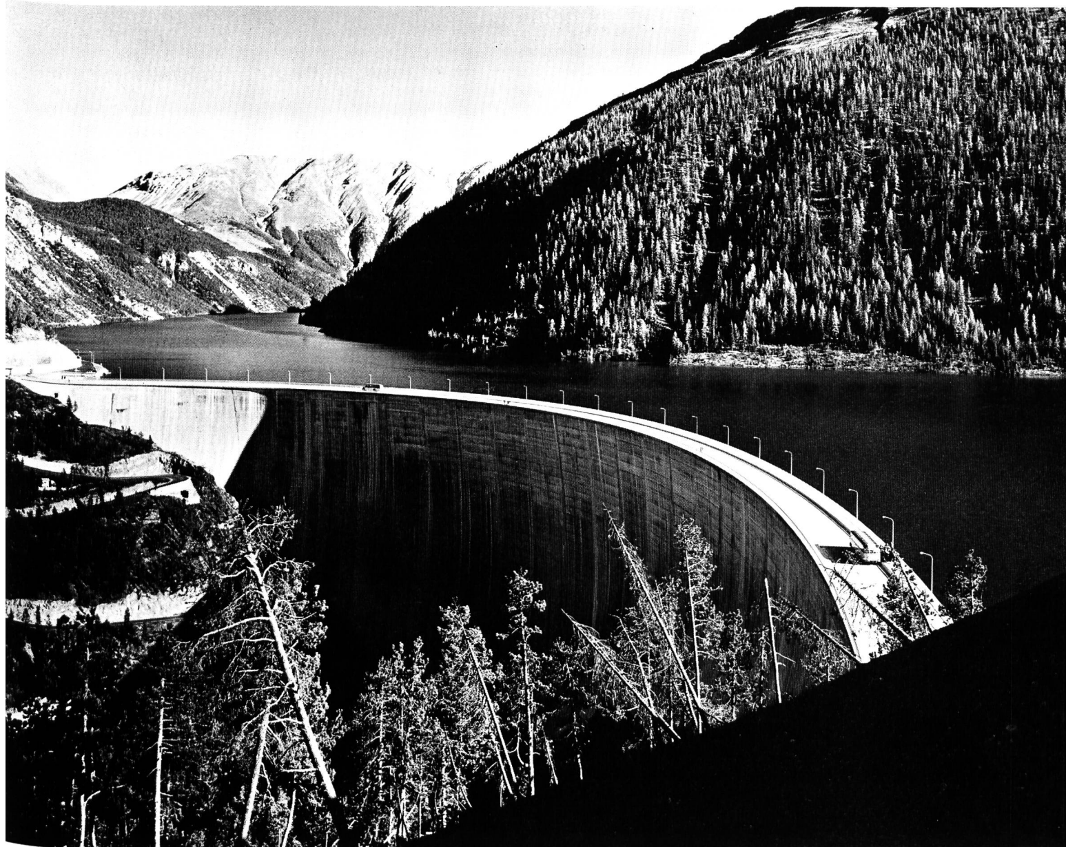
Bild 4 Die 130 m hohe Bogenstaumauer Punt dal Gall mit dem Stausee Livigno; Blick nach Val del Gallo
