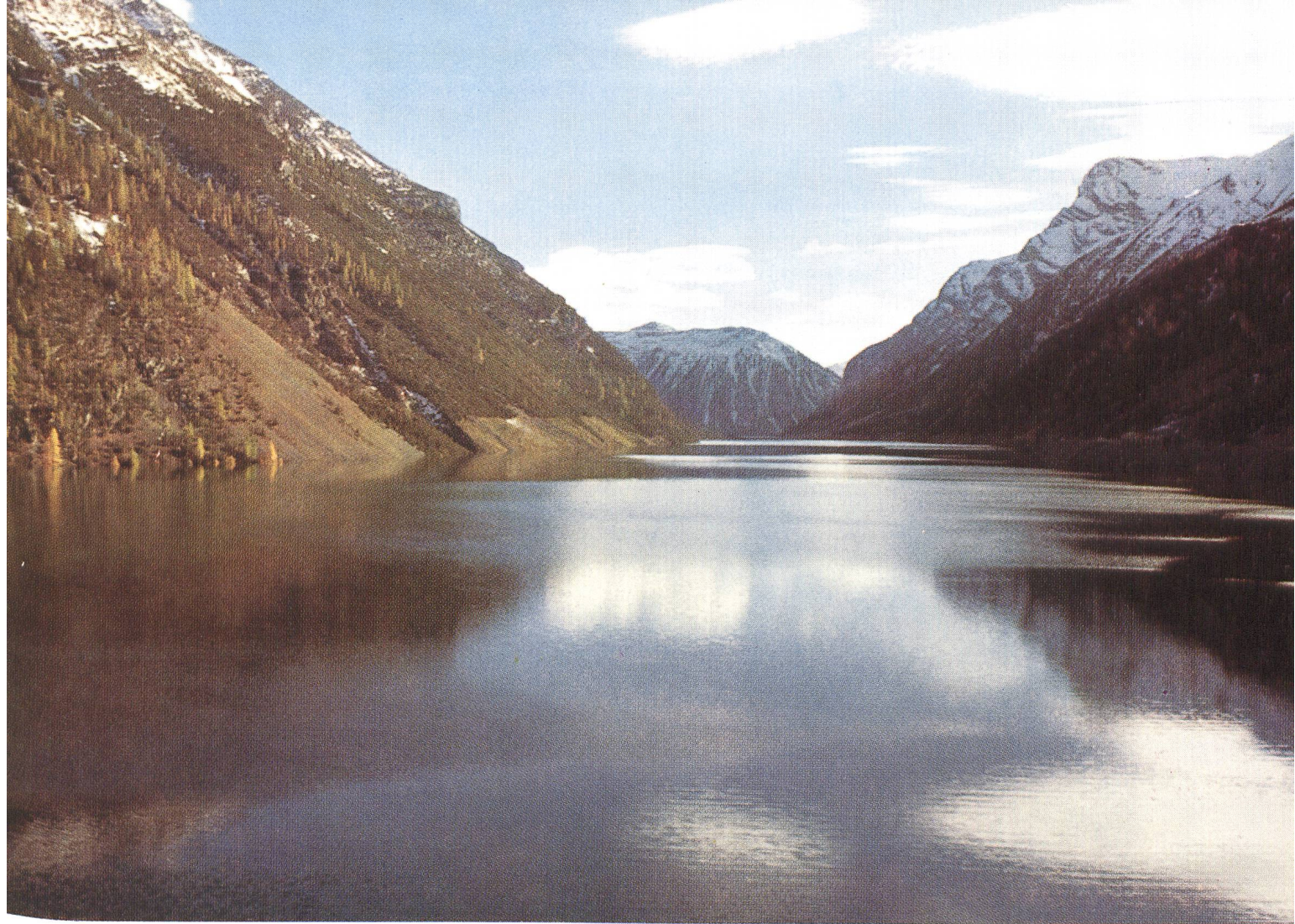
Der grosse Stausee Livigno der Engadiner Kraftwerke AG; Blick von der Talsperre Richtung Livigno.
