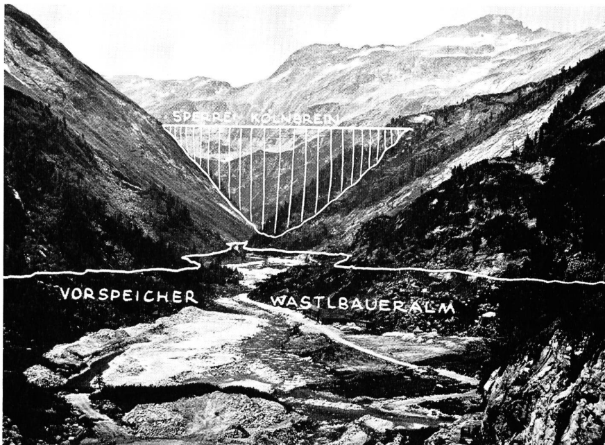
Bild 2 Sperrenstelle für den Hauptspeicher Kölnbrunn des Maltaprojekts (Werkphoto Oesterreichische Draukraftwerke Aktiengesellschaft/Aufnahme Raab)
