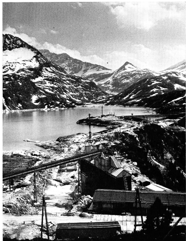
Bild 7 Tauernmoos-See mit alter Sperre im Hintergrund und Aus-hub für die neue Sperre längs der Seebarre (Photo: Oesterreichische Bundesbahnen)
