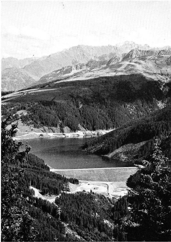
Bild 4 Staudamm Durlassboden mit dem Stausee im obersten Gerlostale (Werkphoto der Tauernkraftwerke AG/Aufnahme W. Zabel)
