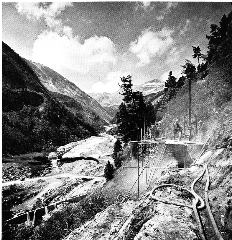
Bild 3 Aushubarbeiten für die Sperren Galgenbichl des Vorseichers Wastlbaueralm im Maltatal (Werkphoto: Oesterreichische Draukraftwerke Aktiengesellschaft/Aufnahme Raab)
