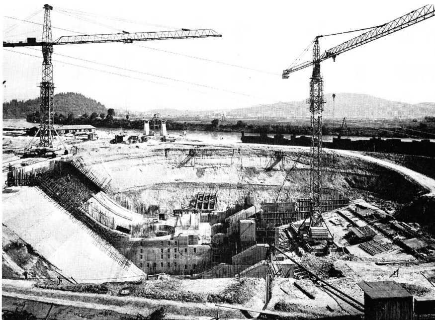
Bild 1 Die durch Grundwasserabsenkung trockengehaltene Baugrube für das Krafthaus Rosegg an der Drau (Werkphoto: Oesterreichische Draukraftwerke Aktiengesellschaft/Aufnahme Raab)
