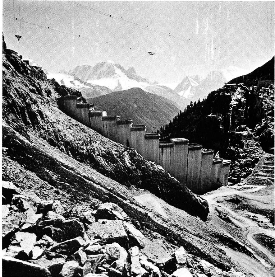
Bogenstaumauer Emosson und Felsausbruch des rechten Widerlagers; im Hintergrund links Aiguille Verte, rechts Mont Blanc (Photo: M. Darbellay, Martigny)
