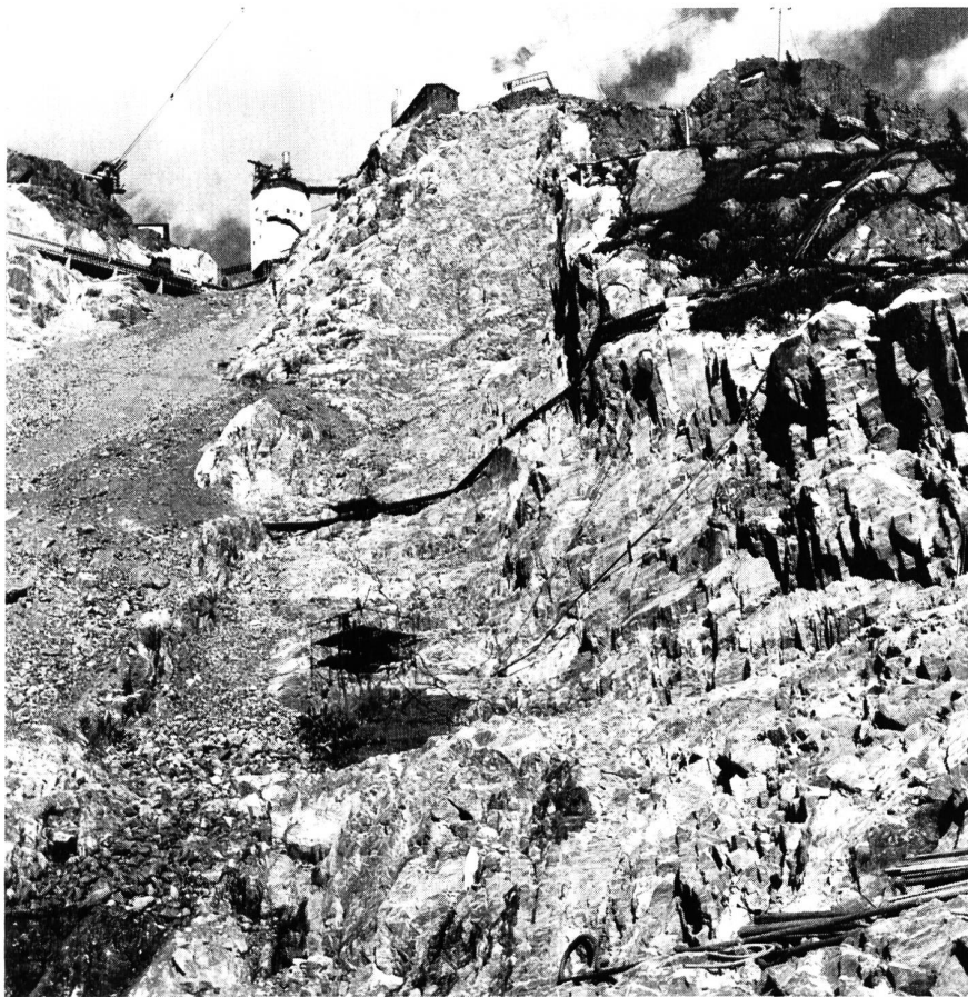
Bild 4 Abgeschlossener Fundamentaushub auf der linken Flanke
