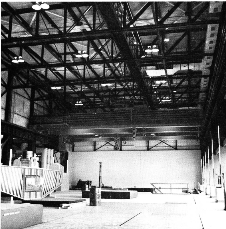
Bild 25 Der Maschinensaal von Outardes 4
