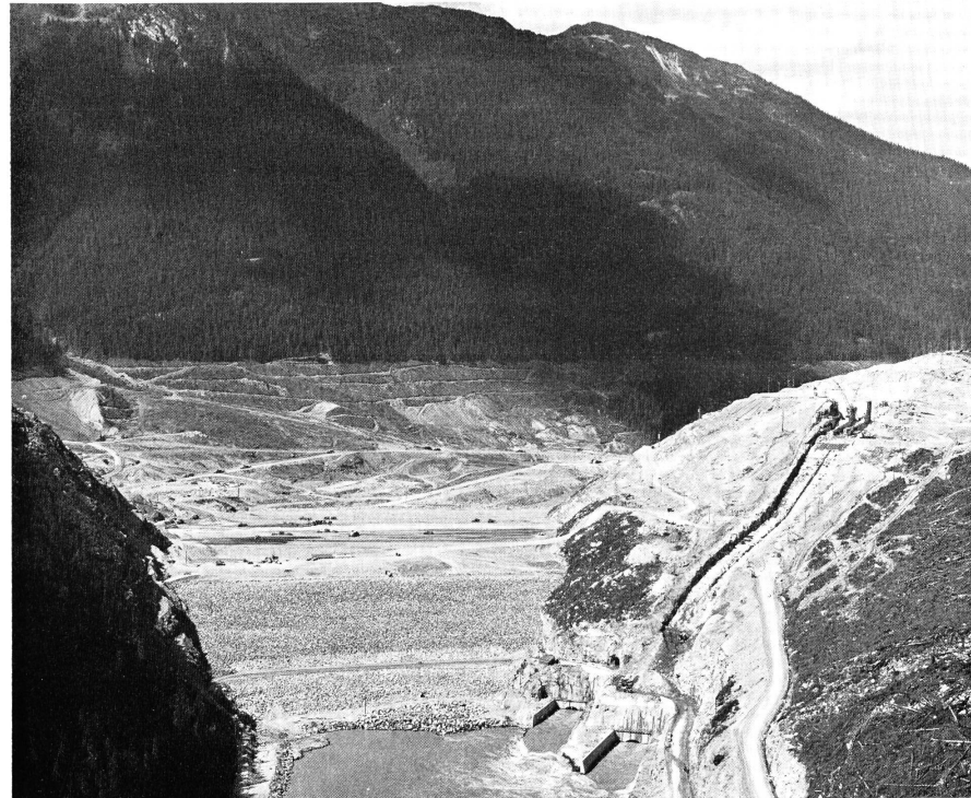
Bild 80 Uebersichtsbild über die Bauarbeiten am Mica-Dam am oberen Columbia River, rechts im Bau befindliche Wehrkonstruktion und Aubruch der Hochwasserschussrinne, unten rechts Ausläufe der Umleitstollen
