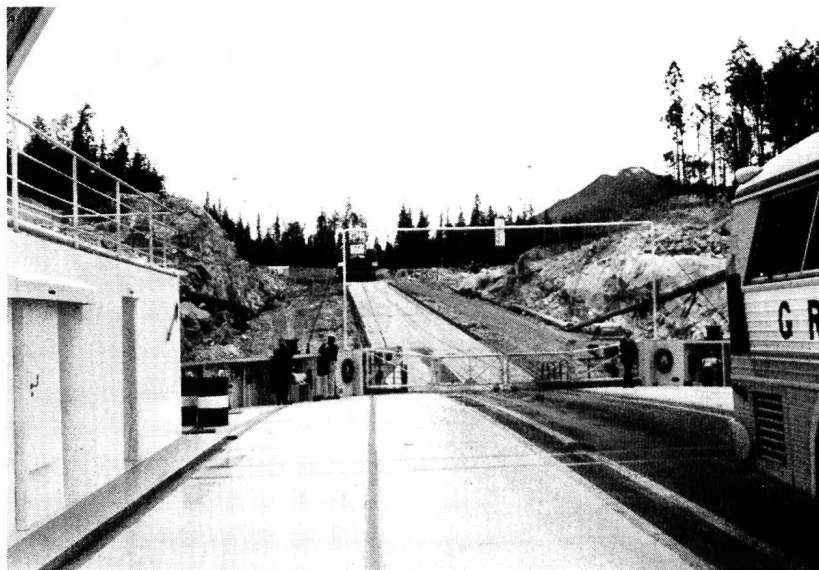
Bild 93 Blick von der Fähre auf die steile Zufahrtsrampe, die für stark variierende Seestände konstruiert werden musste
