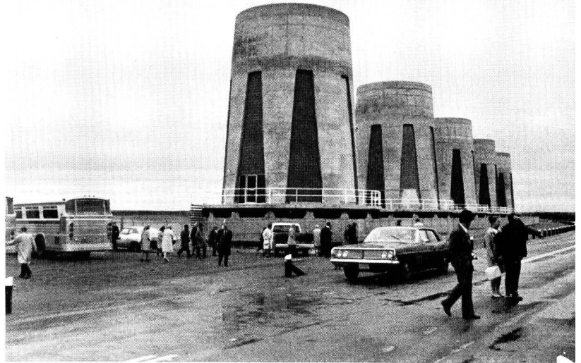
Bild 59 Eisenbetontürme zur Aufnahme der Abschlussorgane für die Wasserentnahme aus dem Stausee Diefenbaker
