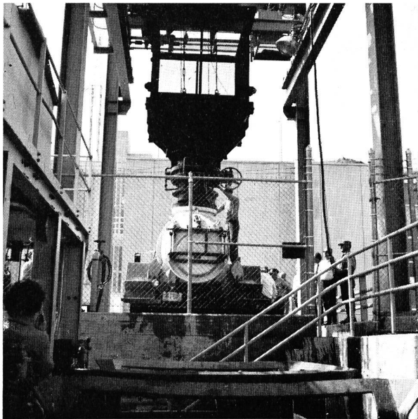
Bild 33 Fischverladekorb und -Transportauto am Kraftwerk Mactaquac
