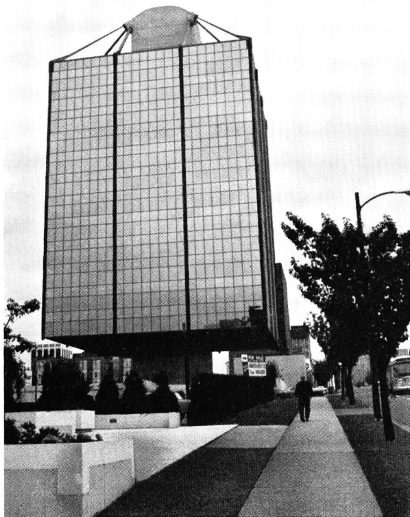
Bild 106 Hochhaus eigenartiger Konstruktion im Stadtzentrum von Vancouver; das ganze Gebäude ist an Stahlbändern aufgehängt
