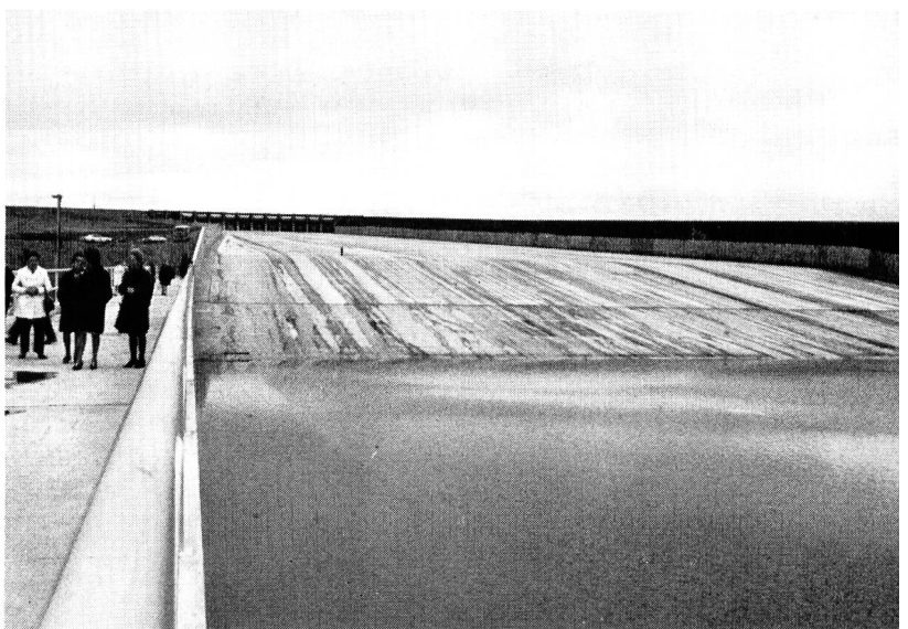
Bild 61 Stark verkürzter Blick vom Unterwasser über die lange und breite Schusssrinne und das Stauwehr für den Hochwasserabfluss
