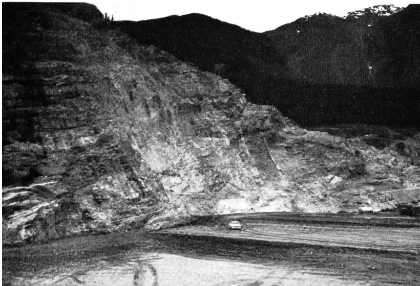
Bild 83 Widerlager der Talsperre und Dammfuss
