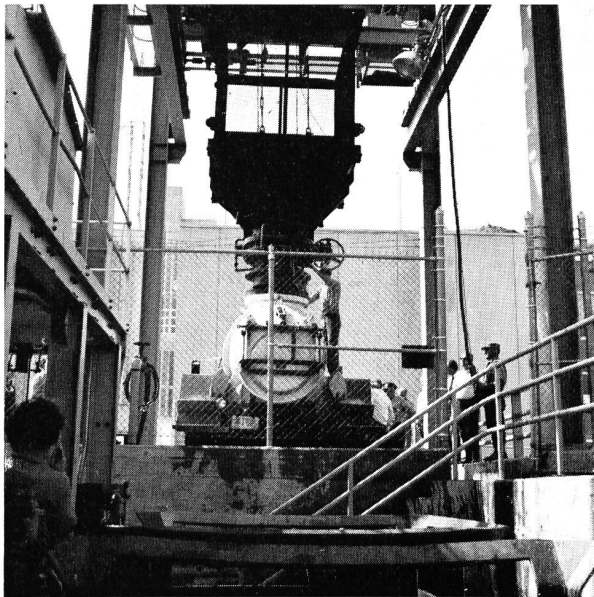
Bild 33 Fischverladekorb und -Transportauto am Kraftwerk Mactaquac
