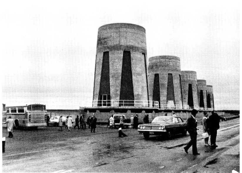
Bild 59 Eisenbetontürme zur Aufnahme der Abschlussorgane für die Wasserentnahme aus dem Stausee Diefenbaker
