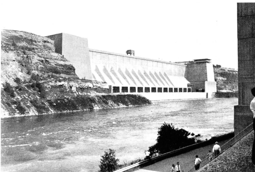
Bild 52 Aussenansicht des neuerstellten USA-Kraftwerks, welches das Gefälle der Niagara-Stufe ausnützt
