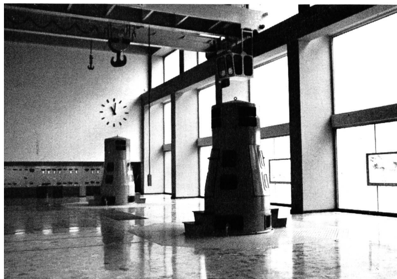
Bild 4 In der schönen Talsperrenzentrale Ova Spin
