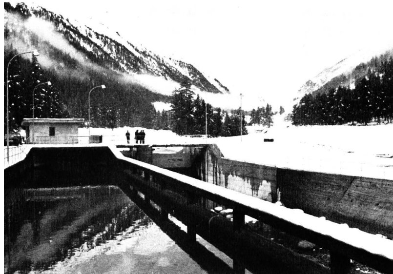
Bild 3 Wasserfassung des Vallemberbachs im äusseren Val Susauna
