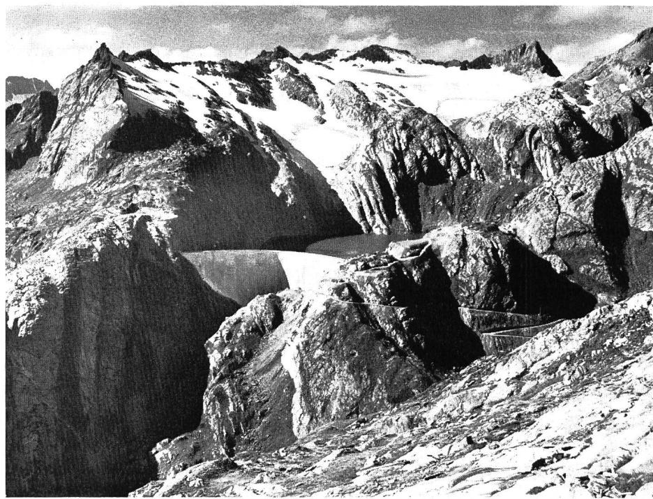
3,3 Mio m<sup>3</sup> durch Absenkung um 22 m unter den natürlichen Spiegel und 6,7 Mio m<sup>3</sup> durch ebensoviel Aufstau gewonnen. Die alten kleineren Sperrmauern am Nord- und Südende sind durch neue Gewichtsmauern auf gutem Gneis ersetzt.
