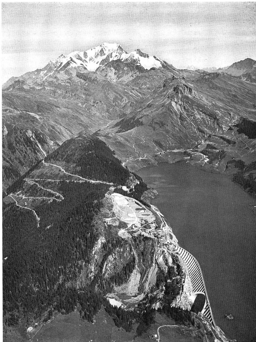
Fig. 52 Stausee Roselend (1557 m) mit der Talsperre aussergewöhnlicher Bauart; im Hintergrund das dominierende Mont Blanc-Massiv (4810 m)
