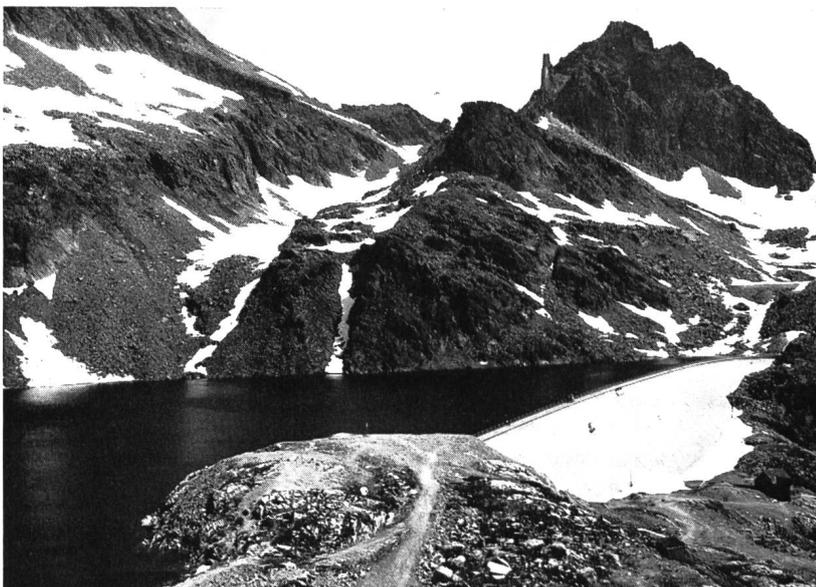
tion de l'ouest, les apports de 26,1 km<sup>2</sup> appartenant au bassin voisin du ruisseau Zirknitz. En développant les collecteurs d'adduction, tant vers l'ouest que vers l'est, on doit au stade final réunir dans ce lac les précipitations d'un bassin versant de 111,3 km<sup>2</sup>, drainé par les affluents de la Möll issus de la crête principale des Alpes, sur la distance de 32 km<sup>2</sup> séparant la route du Grossglockner du Tunnel des Tauern.
