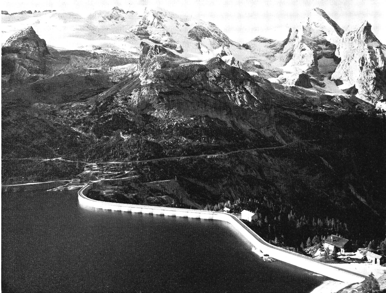
Fig. 25 Fedaiia-Stausee (2053 m) unter der Marmolada (3342 m) in den Dolomiten; westliche Pfeilerstaumauer gegen das Avisio-Tal
