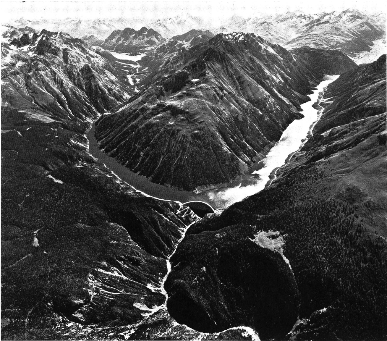
Fig. 8 Grenzgebiet Schweiz/Italien mit Talsperre Punt dal Gall, rittlings auf der Grenze, und Stausee Livigno (1805 m) — grösstenteils in Italien gelegen — der Engadiner Kraftwerke; im Hintergrund links der Speichersee San Giacomo di Fraële (1949 m) der Azienda Elettrica Municipale di Milano, im Vordergrund Spöltal und Grenzzone des Schweizerischen Nationalparks am Ofenberg
