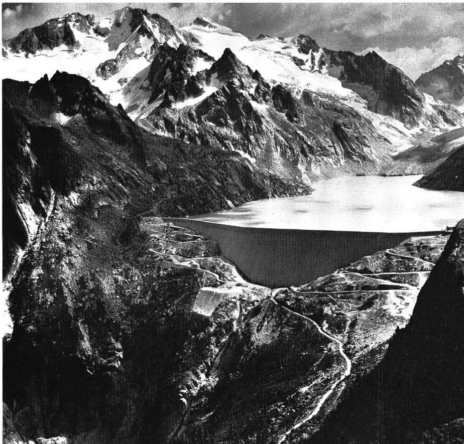
(151) 1484 m ü. A. mit 50 Mio m<sup>3</sup> Nutzraum vollendet worden. Im Belvisotal, mit 47 km<sup>2</sup> durch Beileitungen vergrössertem Einzugsgebiet, staut ihn eine 138 m hohe Bogen-gewichtsmauer.
