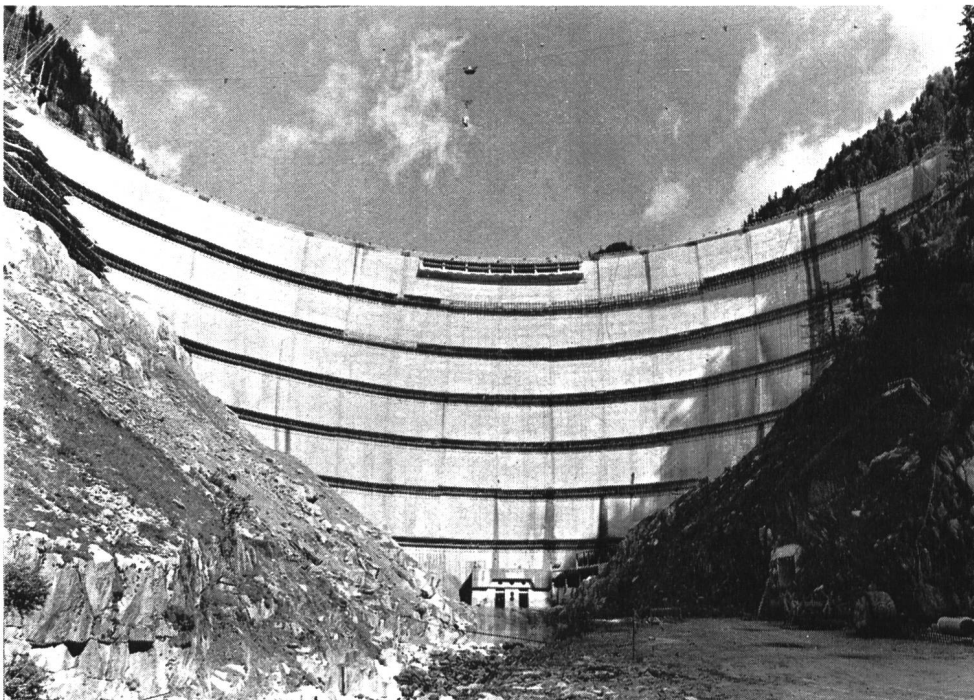
Barrage de Gebidem (Aménagement Hydro-Electrique Palier de Bitsch)
