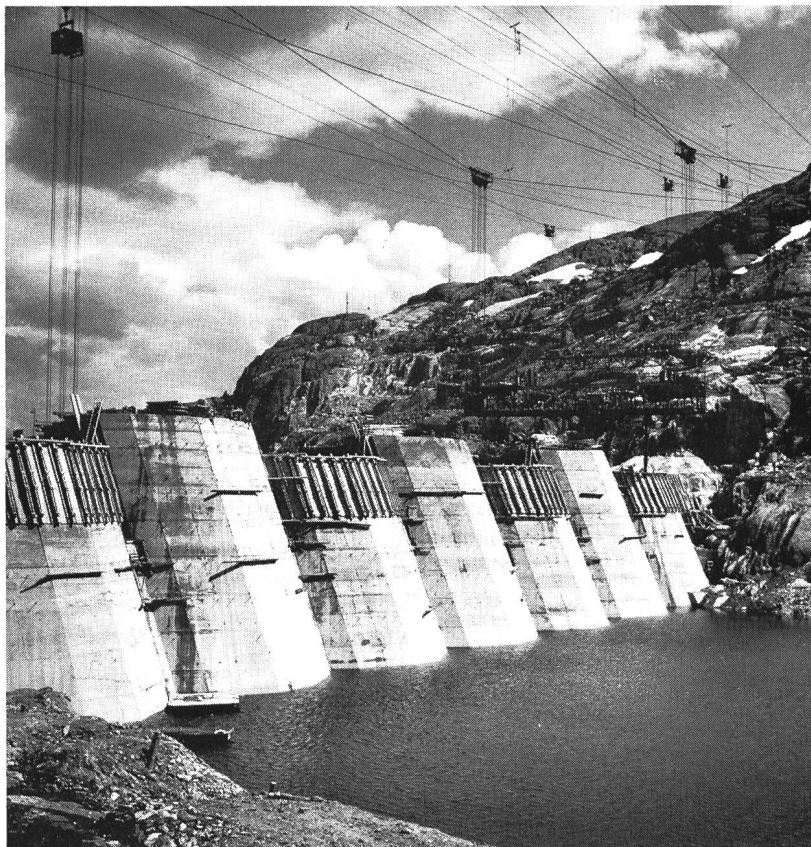
Bild 2 Die Pfeilerstaumauer Lucendro am Gotthardpass, seeseitige Ansicht während des Baues 1945 (Photo H. P. Klauser/Zürich)
