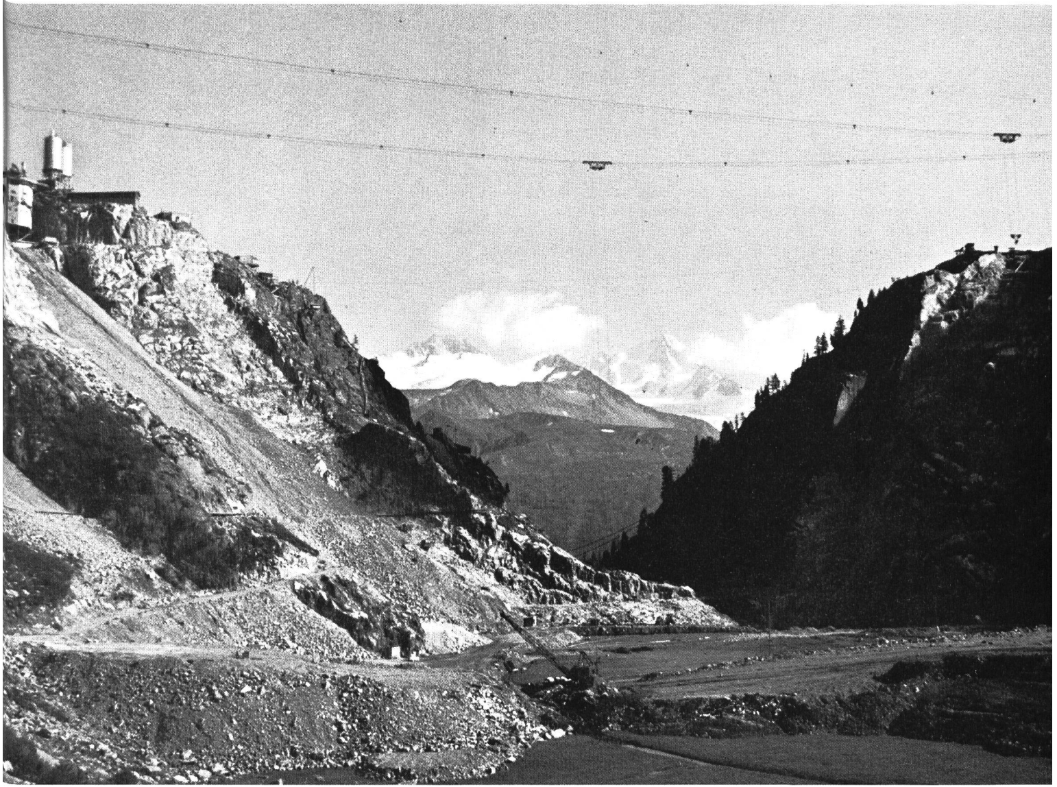
Bild 5 Sperrstelle und Widerlagerausbruch für die im Bau stehende 180 m hohe Bogenstaumauer Emosson der schweizerisch-französischen Emosson-Kraftwerke; im Hintergrund Aiguille du Chardonnet, 3824 m ü. M. (Photo G. A. Töndury)
