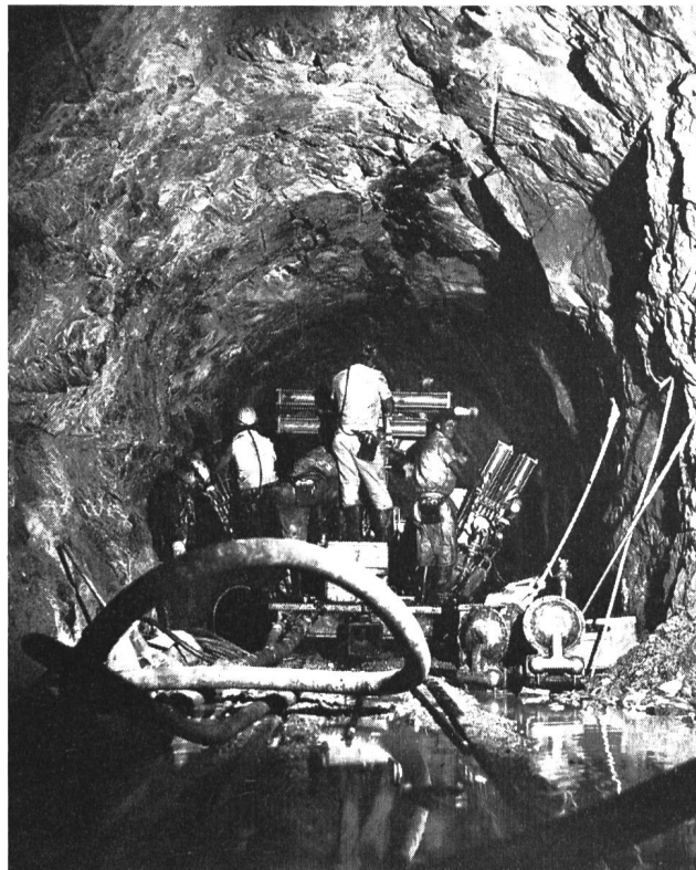
Bild 4 Druckstollenarbeiten mit Bohrjumbo für das Kraftwerk Santo Domingo (240 MW) in Venezuela
