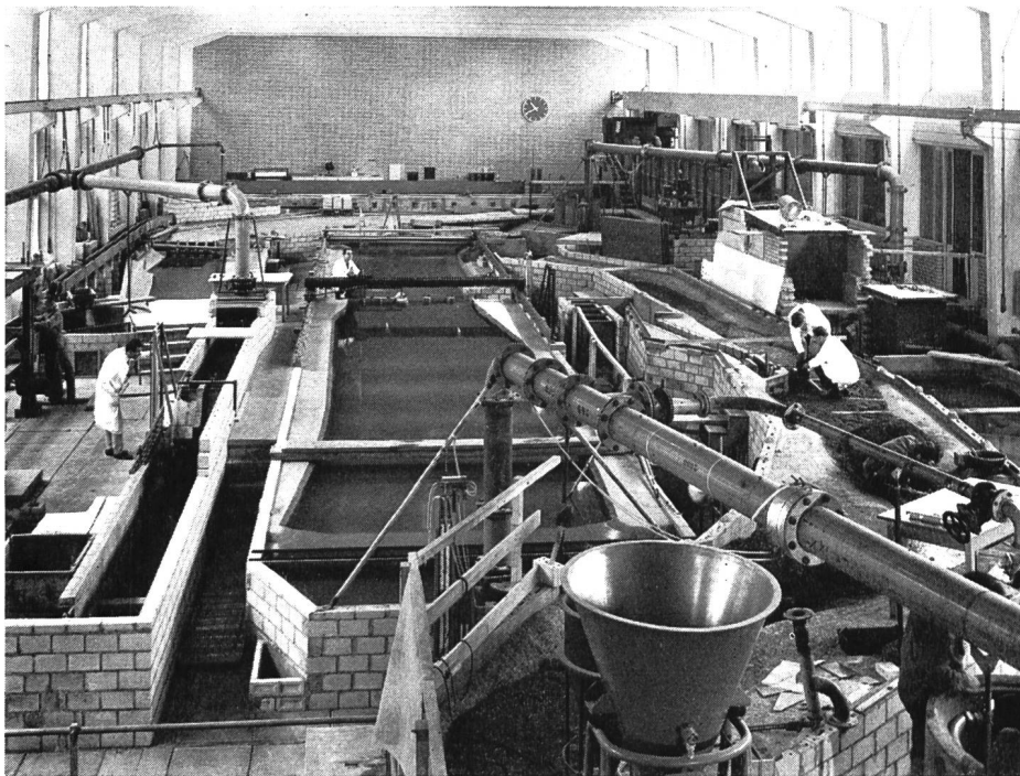
Bild 9 Die neue Versuchshalle der VAWE im Jahre 1965. Modelle von links nach rechts: Kraftwerk Bremgarten Zufikon; Kraftwerk Jaguará, Brasilien; Kraftwerk Flumenthal; Wasserfassung Pativilca, Peru
