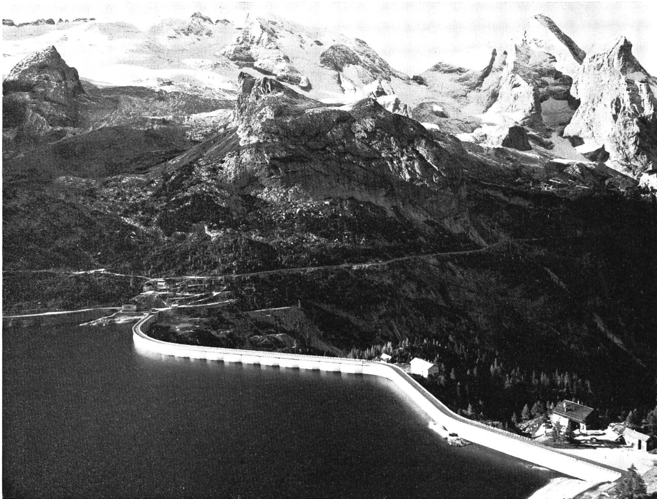
Fig. 25 Fedaia-Stausee (2053 m) unter der Marmolada (3342 m) in den Dolomiten; westliche Pfeilerstaumauer gegen das Avisio-Tal
