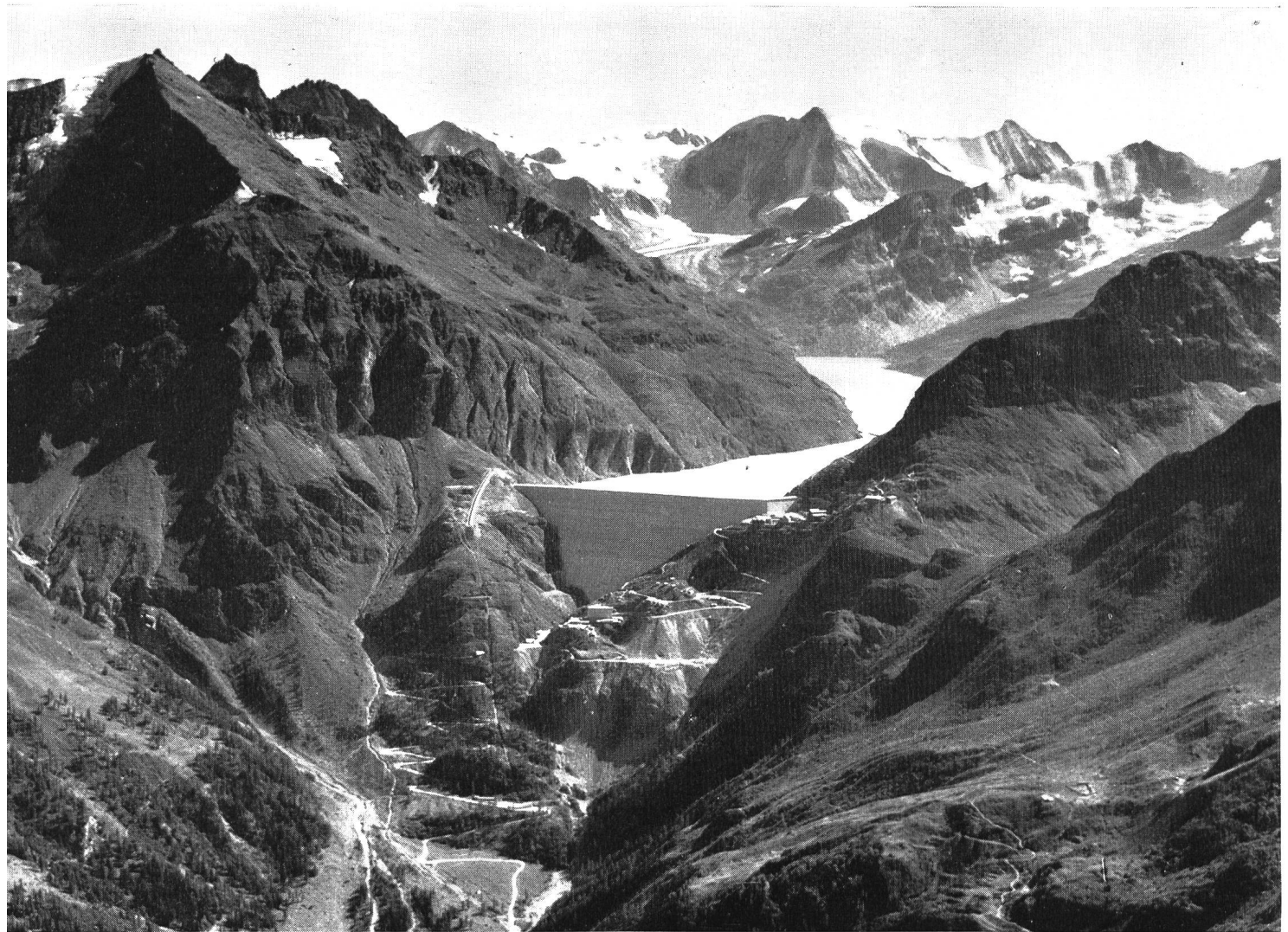
Fig. 48 Staumauer Grande Dixence mit Stausee (2364 m) im Val des Dix; im Hintergrund Mont Blanc de Cheilon (3870 m)
