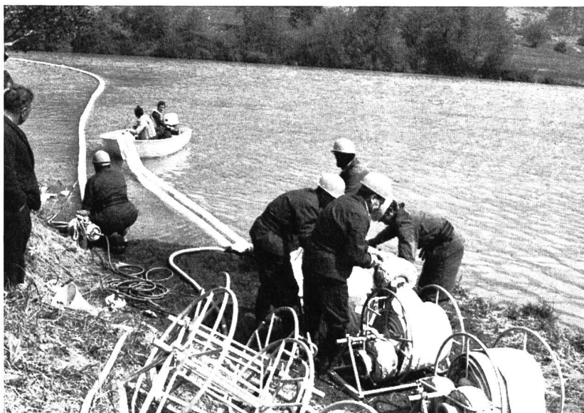
Bild 4 Verlegen der zweiten Schlauchleitung
