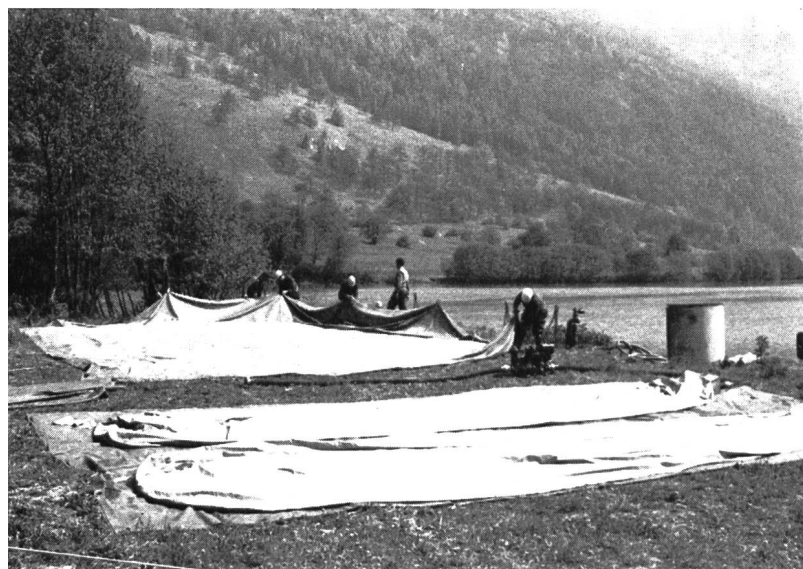
Bild 1 Aufbau der wasserdichten Blachen für die Einleitung des im Fluss abgesaugten Oel/Wasser-Gemisches; im Vordergrund zwei lange Stoffbehälter für den Abtransport des abgeschöpften Oels mittels Camions
