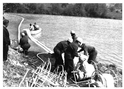
Bild 4 Verlegen der zweiten Schlauchleitung
