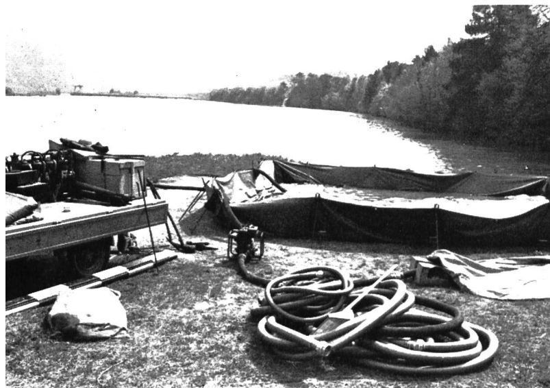
Bild 2 Aufgestellter Notbehälter während des Hineinpumpens der aus dem Rhein entnommenen Flüssigkeit
