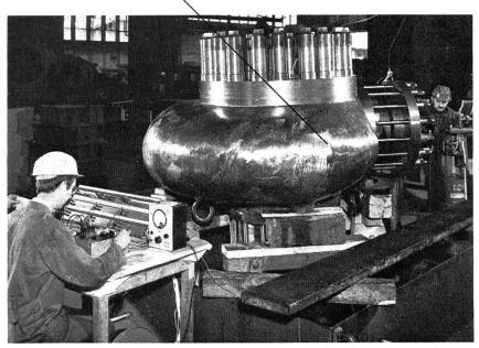
Pumpengehäuse von 9,1 t Gewicht für das 600 MW Atomkraftwerk «Würgassen» bei der Spannungs-Dehnungsmessung unter Betriebsdruckbedingungen von 170 atü zusammen mit dem Kunden und der staatlichen Abnahmebehörde.
