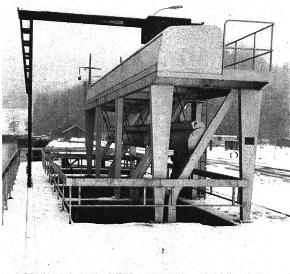
Kühlwasserfassungen der Atomkraftwerke Beznau I + II Je 3 Rechen und automatische, stationäre Rechen-Rei- nigungsmaschinen
