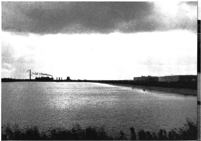
Bild 14 Teilansicht des grossen Klärbeckens mit 8 Mio m 3 Nutzinhalt
