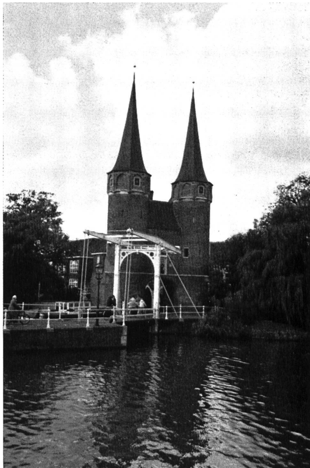
Bild 1 Eines der turmbewehrten Stadttore von Delft mit der typischen Klappbrücke
