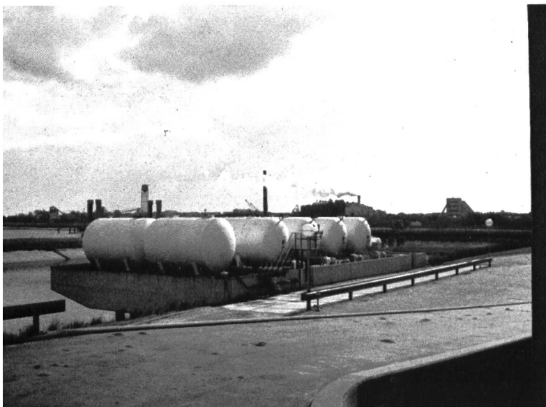
Bild 18 (unten) Tanks mit Chlor und Fluor für die chemische Aufbereitung des Trinkwassers
