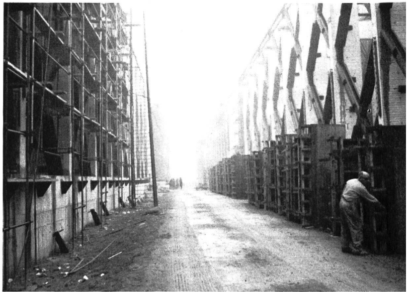
Bilder 25 (links) und 26 (oben) In einer Bodensenke werden die riesigen Senkkasten an Land erstellt — sie erinnern an eine im Entstehen begriffene moderne Stadt — um nach Fertigstellung geflutet und mit Schiffen kilometerweit zur Einbaustelle für den Abschluss des Brouwershavensche Gat gefahren zu werden
