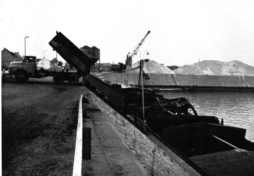
Bilder 1 und 2 Moderne Umschlaganlagen und Gross-Silo im neuen Koblenzer Rheinhafen
