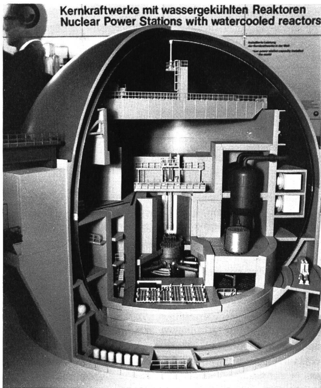
Bild 2 Schnittmodell des Kernkraftwerks Biblis am Rhein. Druckwasserreaktor für 3 440 MWth Foto: Kraftwerk Union
