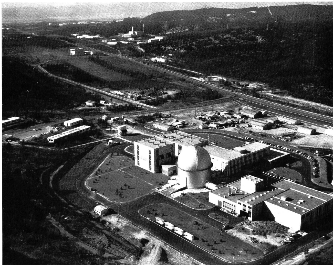
Bild 13 Luftbild der Reaktoranlage Rapsodie im Kernforschungszentrum Cadarache
