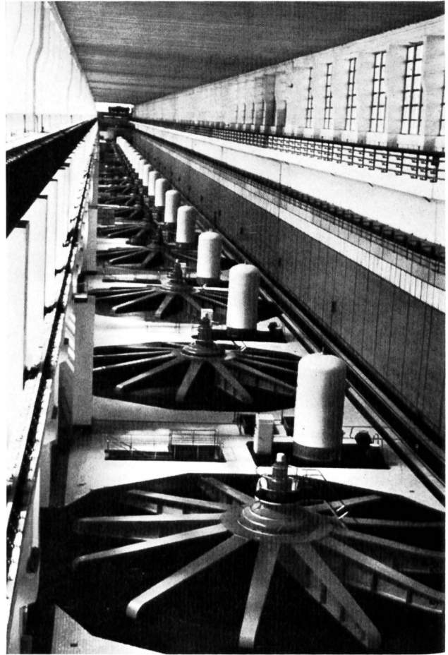
Bild 72 Blick in die riesige Zentrale Wolgograd mit den 22 Kaplan-turbinen und Generatoren.
