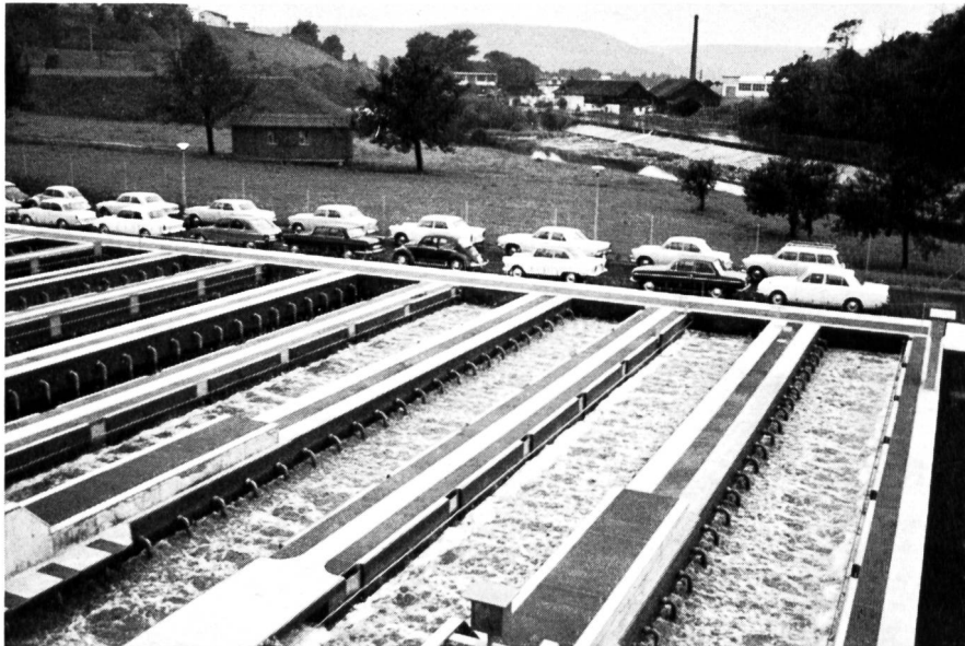
Bild 5 Blick auf einen Teil der Belüftungs- becken
