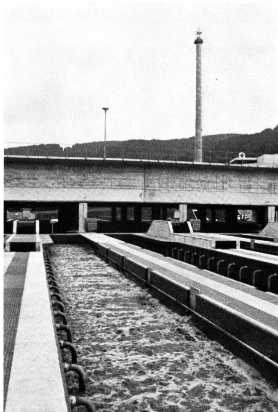
Bild 1 Blick auf die zweistöckige Kläranlage: Vorklärbecken im oberen Stock, im Vordergrund Belüftungsbecken.
