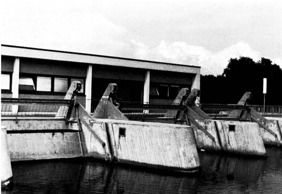
Bild 7 Ortsfeste Rechenreinigungsmaschine des Kraftwerkes Aarberg, Konstruktion Fäh.
