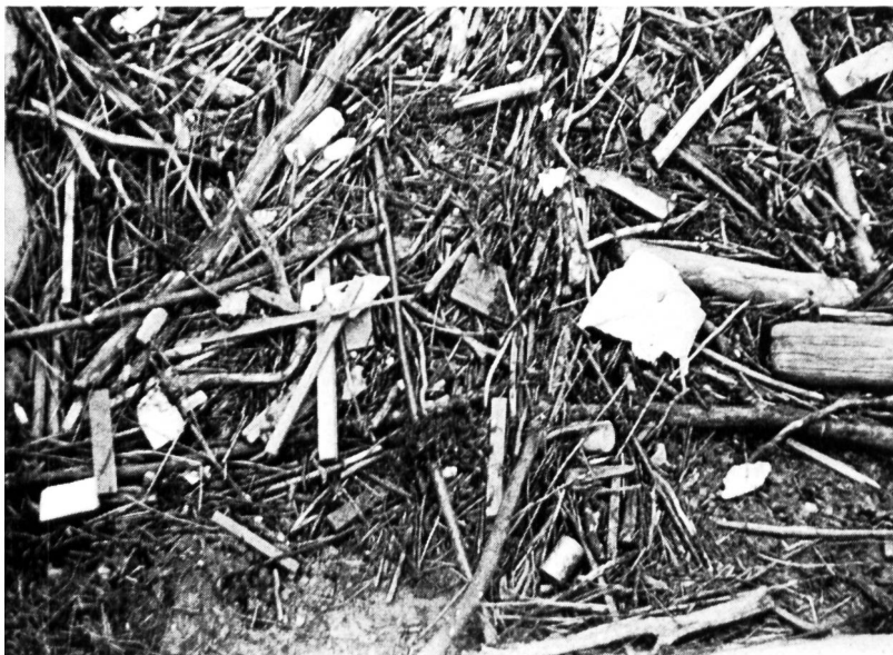
Bild 2 Geschwemmsel im Auffangbecken des Kraftwerkes Aarberg; mit dem natürlichen Treibzeug werden auch viel Zivilisationsrückstände angeschwemmt.
