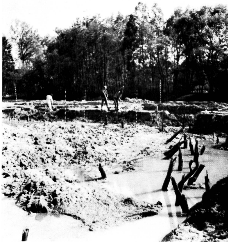
Bild 7 Römische Ufersicherung an der Broye bei La Sauge
