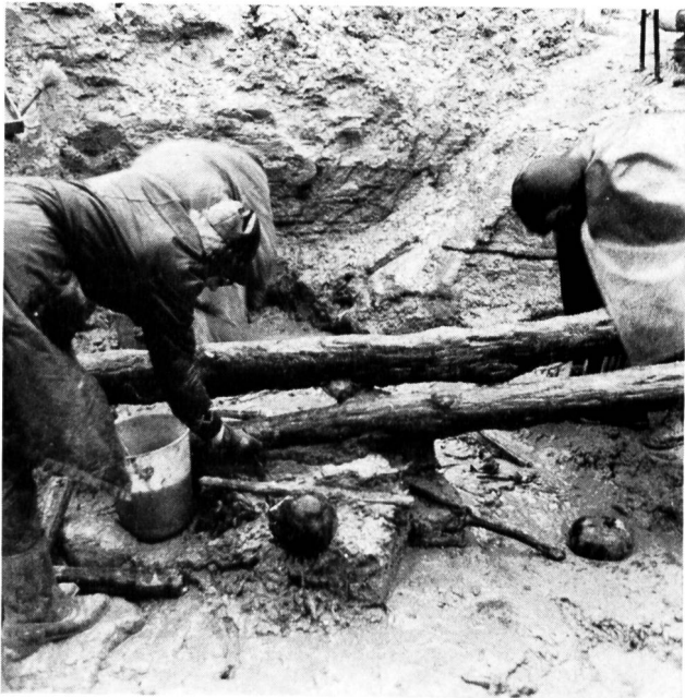
Bild 4 Keltische Brücke bei Cornaux. Die Skelette lagen eingeklemmt unter den Balken der eingestürzten Brücke
