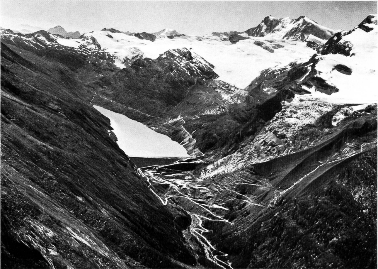
Bild 1 Der bei Vollstau 100 Mio m 3 Nutzwasser fassende Mattmark-Speicher aus der Vogelschau; der Vollstau soll erstmals in diesem Herbst erreicht werden.
