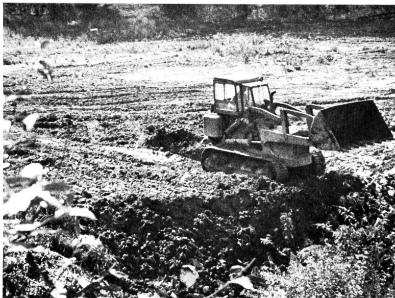
Bild 2 Bei der geordneten Deponie werden Müllschichten bestimmter Höhe mit Erde bedeckt und verdichtet; so können in hygienisch einwandfreier Weise immer neue Schichten aufgebracht werden (aus Dokumentarfilm «Abfall — Schattenseite des Ueberflusses»).
