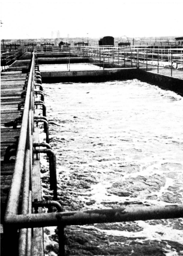
Bild 9 Belüftungsbecken.
