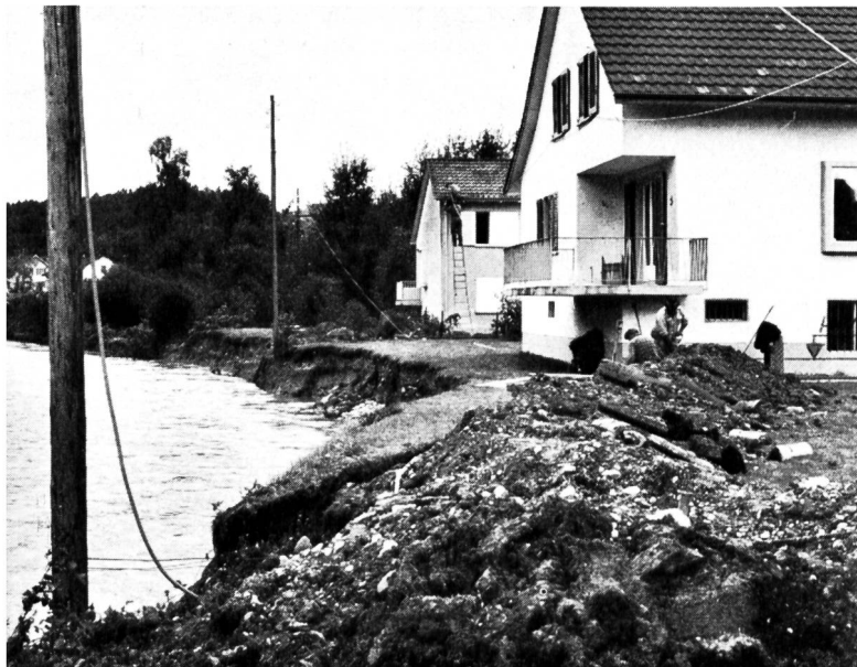
Bild 2 Murg in Matzingen. Wiederherstellungsarbeiten an der Auslenkkurve.
