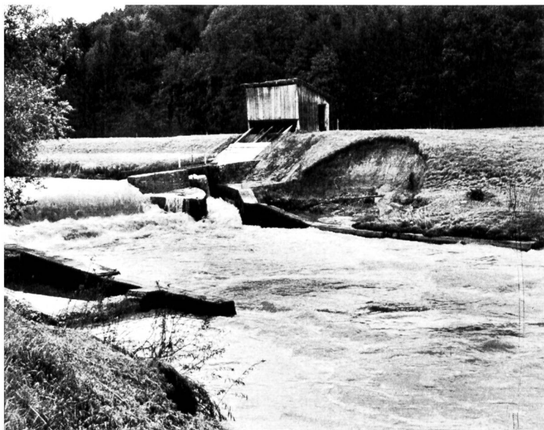
Bild 3 Murg. Uferschäden beim Wehr Aumühle.
