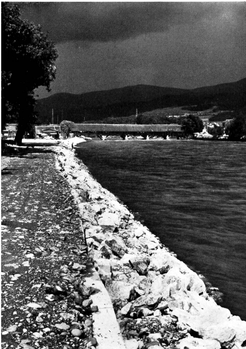
Bild 3 Holzbrücke bei Wangen an der Aare; neue Uferausbildung vor der Fertigstellung.
