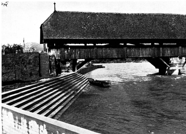
Bild 2 Holzbrücke bei Wangen an der Aare; neue Uferausbildung am rechten Widerlager.
