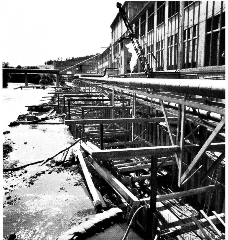
Bild 12 Bau der Ufermauer und des Abwasserkanals längs der Cellulosefabrik Attisholz. Blick flussaufwärts in die Baugrube, August 1968.
