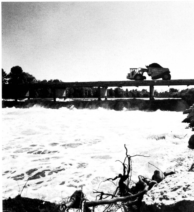
Bild 11 Provisorisches Absturzbauwerk in der Aare, kombiniert mit Dienstbrücke.
