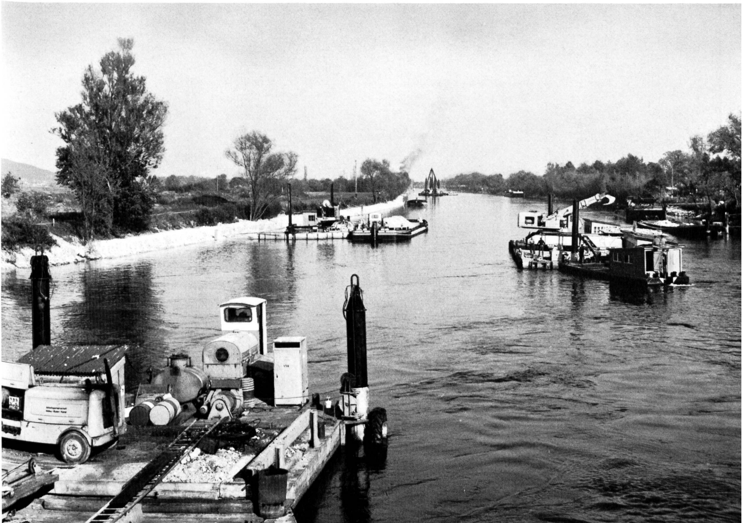
Bild 6 Die Arbeitsfront im Nidau-Bürenkanal.
