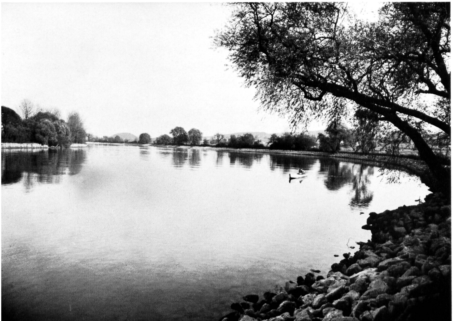
Bild 8 Mäanderstrecke der Aare, gesicherte Aussenseite der Krümmung Leuzigen.
