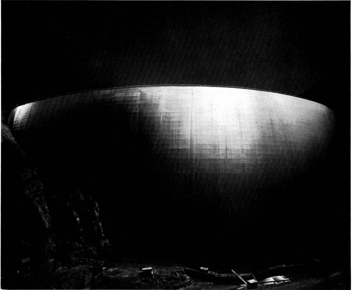
Staumauer Punt dal Gall der Engadiner Kraftwerke
