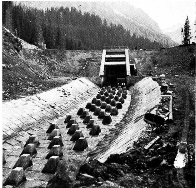
Bild 4 Ablaufgerinne mit Einbauten für Energievernichtung
