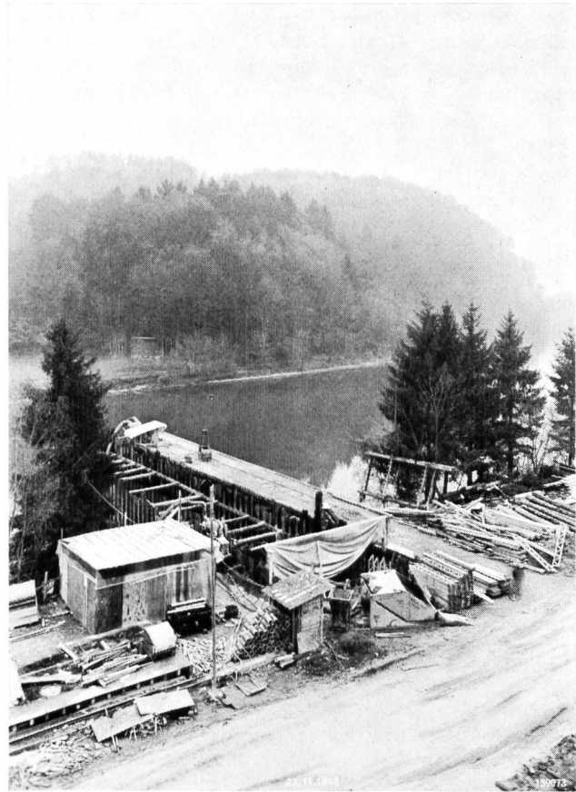
Bild 12 Baugrube für Kühlwasserrückgabe
