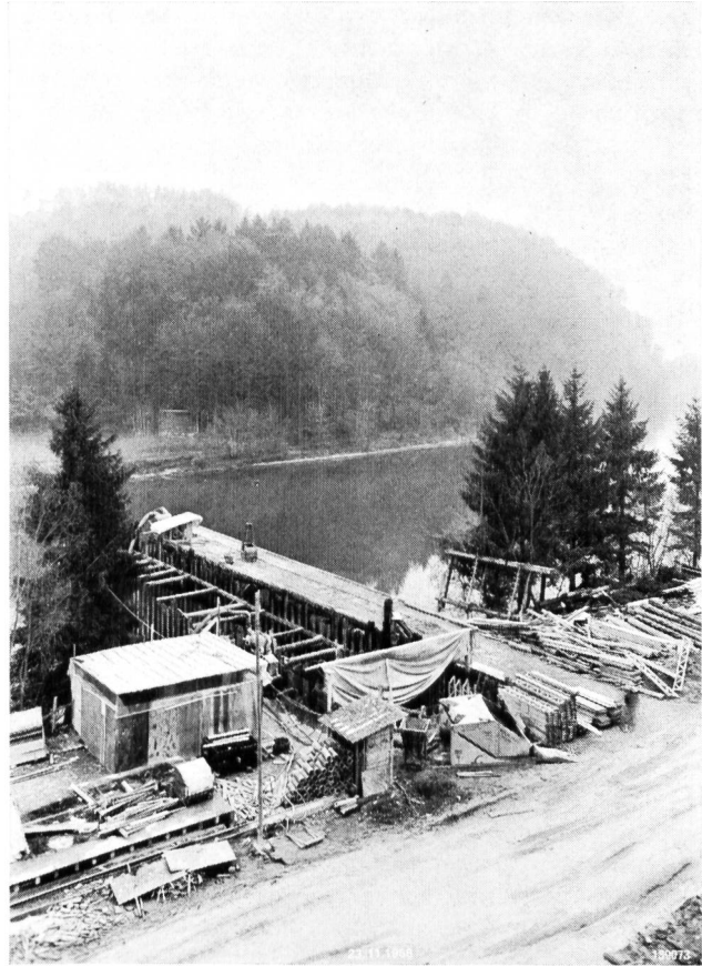
Bild 12 Baugrube für Kühlwasserrückgabe
