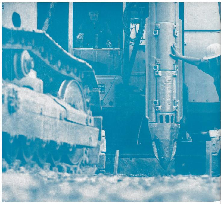
Tiefenverdichtungen nach dem Rütteldruckverfahren. Zur Erhöhung der Tragfähigkeit anstehender Böden oder künstlicher Aufschüttungen. Zur Reduktion der Wasserdurchlässigkeit (k-Wert) grobdurchlässiger Kiese und Kiessande.
