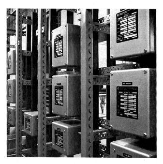
Die Verwendung von Messumformern gestattet den Bau moderner, raumsparender Schaltwarten nachdem Prinzip der Schwachstrommessung. Zusätzliche Messaufgaben wie Mehrfachanzeige eines Messwertes, Weitergabe von Messwerten auf Fernmesskanäle und Summen- oder Differenzbildung von Messwerten lassen sich auf einfachste Art lösen.
