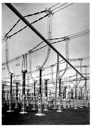
Bild 6 Dreipolige Doppelschlagtrennergruppe zur Trennung der Sammelschienen
