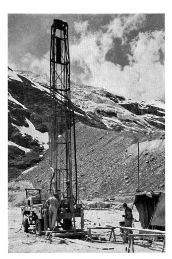
Bild 1 Einsatz einer Rotary-Bohrmaschine in Mattmark
