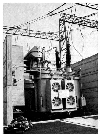
Bild 5 Dreipolige Transformatorengruppe für eine Leistung von 600 000 kW
