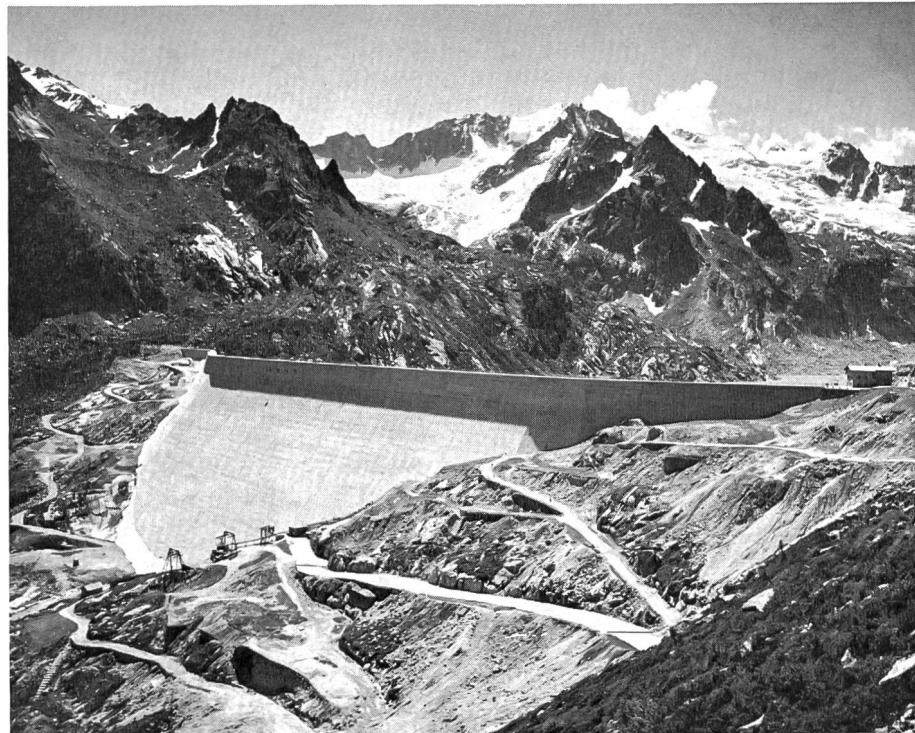
Bild 1 Die 115 m hohe Gewichtsstau- mauer Albigna im Bergell, das bedeutendste Bauwerk des EWZ. Im Hintergrund Cima di Cantone und Cima di Castello (Photo Plattner, St. Moritz)
