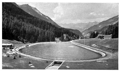
Bild 2 Ausgleichbecken Islas oberhalb Bergün mit 35 000 m³ Nutz-inhalt; Blick talabwärts
