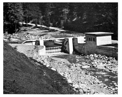
Bild 4 Ausgleichbecken Glaris-Ardüs mit 50 000 m³ Nutzinhalt; im Vordergrund die Zentrale des Kraftwerkes Glaris des EW Davos
