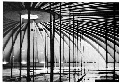
Bild 12 Bauphase eines Grosstanks.
