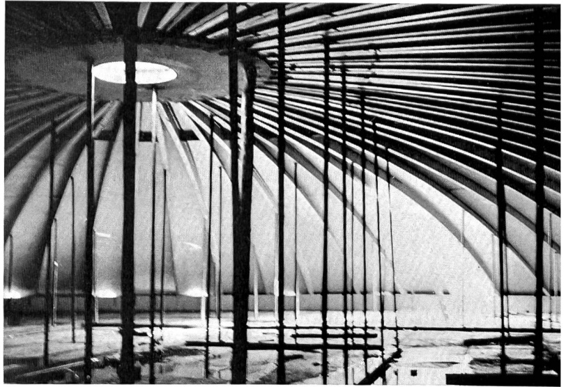
Bild 12 Bauphase eines Grosstanks.
