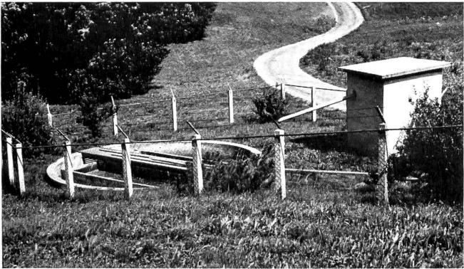
Bild 1 Mechanische Anlage Unterbözberg (Emscherbrunnen)
