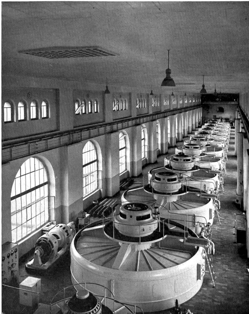
Bild 2 Blick in die Zentrale des 1902 in Betrieb genommenen Aarekraftwerks Beznau. Das typische dieses ältesten aargauischen Grosskraftwerks an der Aare liegt in der grossen Zahl von Maschineneinheiten; beim heutigen Stand in der Maschinen- technik würden diese wahrscheinlich durch zwei Einheiten ersetzt. (Photo G. Vetter VSG/NOK)
