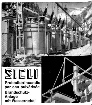
Vue d'ensemble des transformateurs avec les rampes de pulvérisation et détails de construction et de disposition des buses.
