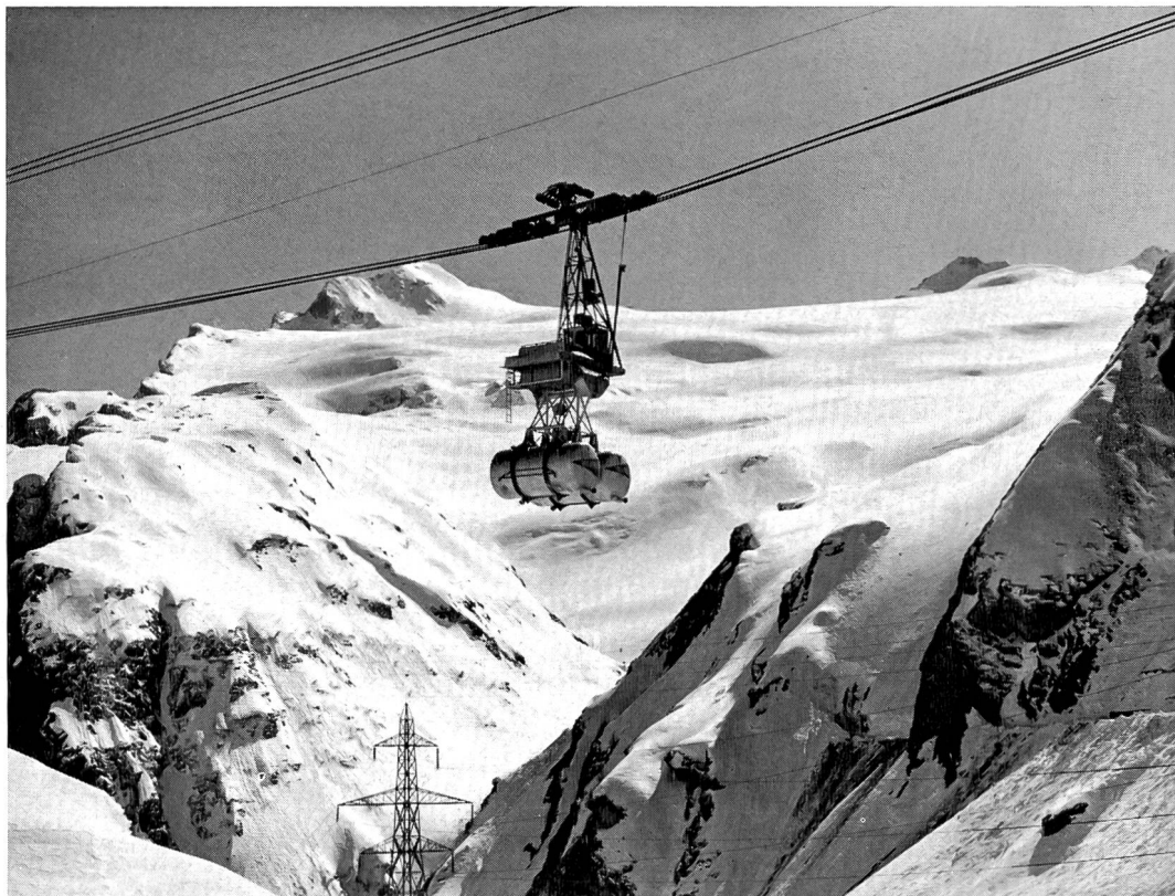
Bild 2 20 t-Seilbahn San Carlo-Robiei mit zwei Zementbehältern zu je 8 t Nutzlast. Im Hintergrund Basodino und Mast der 220 kV-Leitung San Carlo-Grandinagia-Oberhasli.
