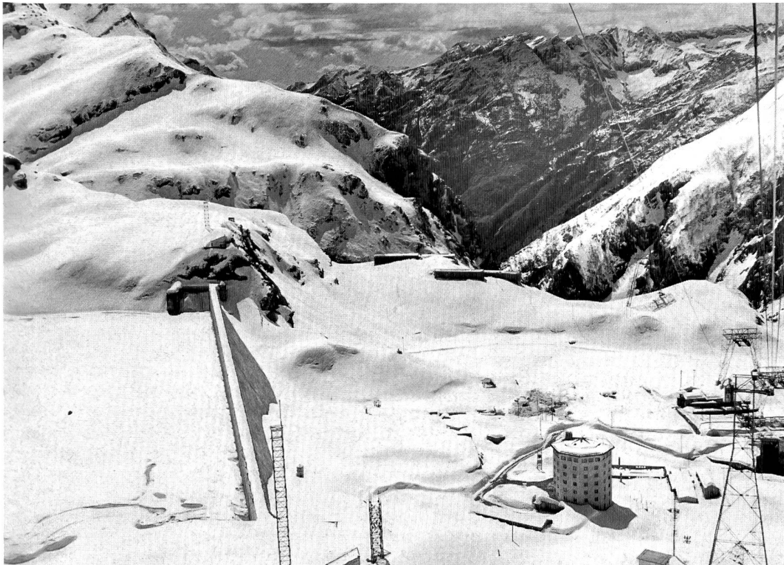
Bild 11 Staumauer, Ausgleichbecken und Logierhaus Robiei mit Station der 20 t-Seilbahn San Carlo-Robiei und der 10 t-Seilbahn Robiei-Cortino (April 1968).
