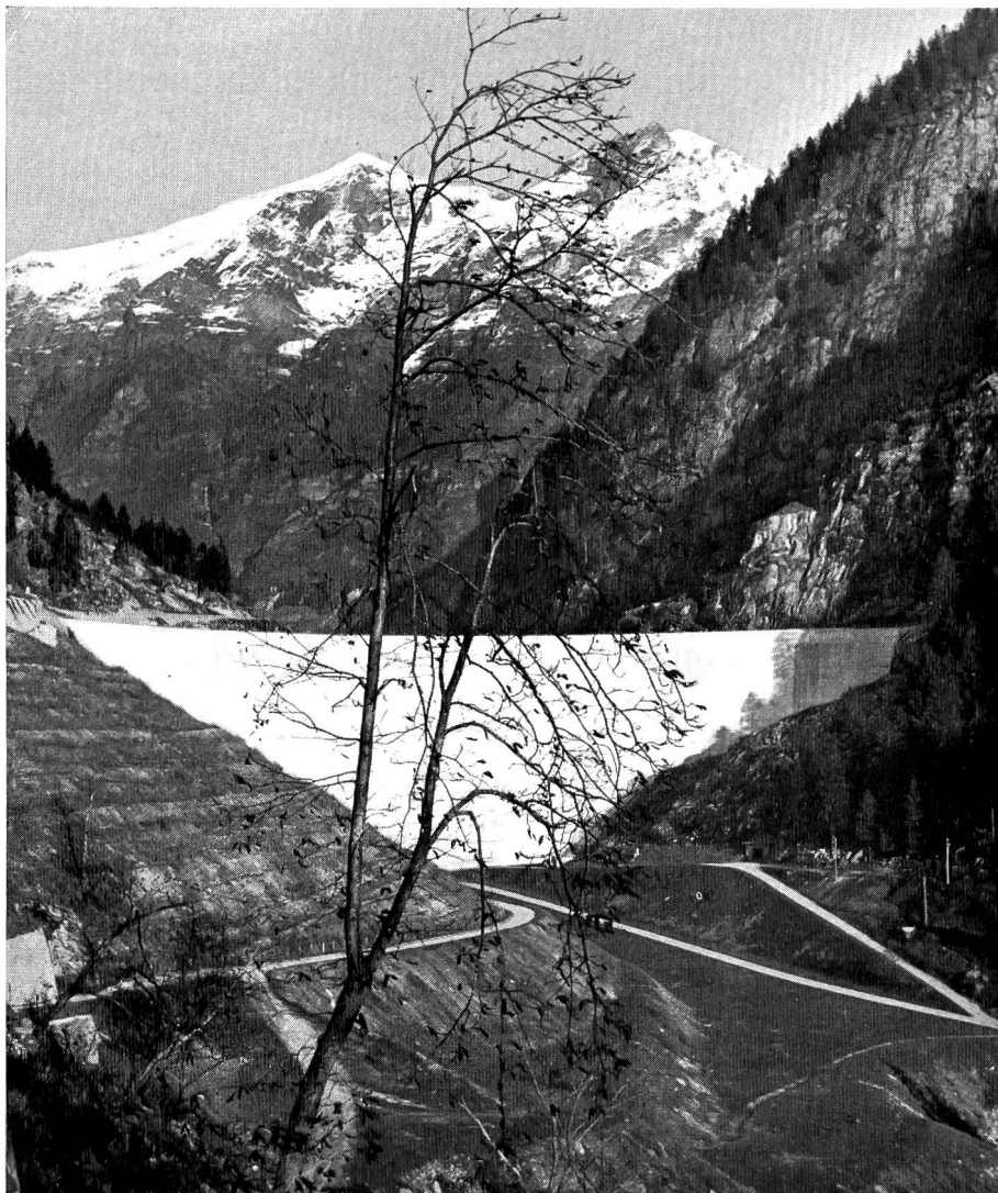
Bild 6 Ansicht der 92 m hohen Bogenstaumauer Malvaglia, die einen Speicherraum von 4 Mio m 3 geschaffen hat. In diesen Speicher mündet der lange, von Olivone kommende Freilaufstollen.
