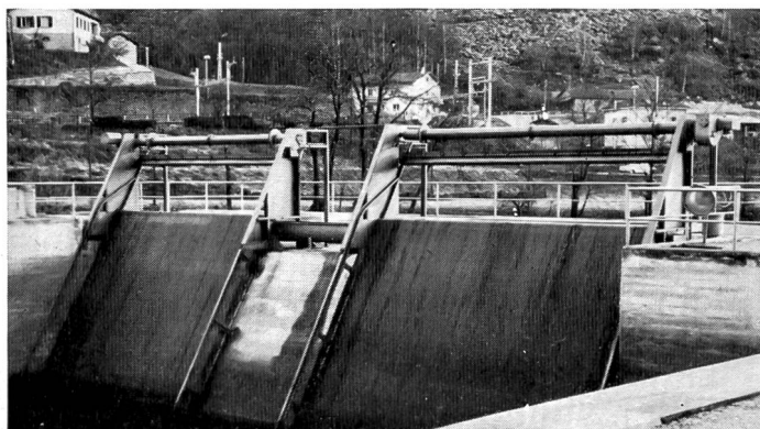
Rechenreinigungsanlage Biaschina der AET
