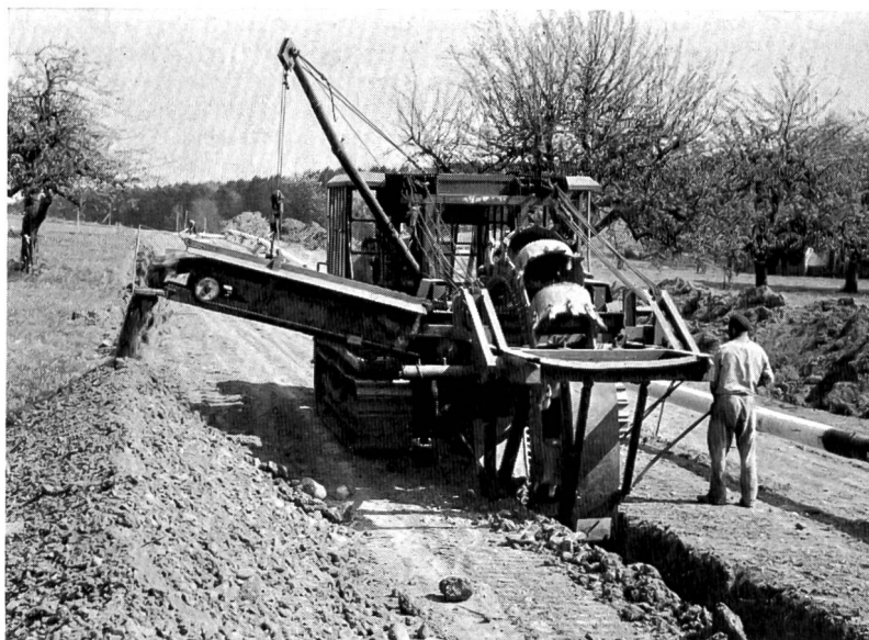
Bilder 2 und 3 Die Grabenfräse an der Arbeit; bei optimalen Verhältnissen beträgt ihre Leistung 180 m/Stunde. Das Aushubmaterial wird über ein Förderband seitlich ausgeworfen.
