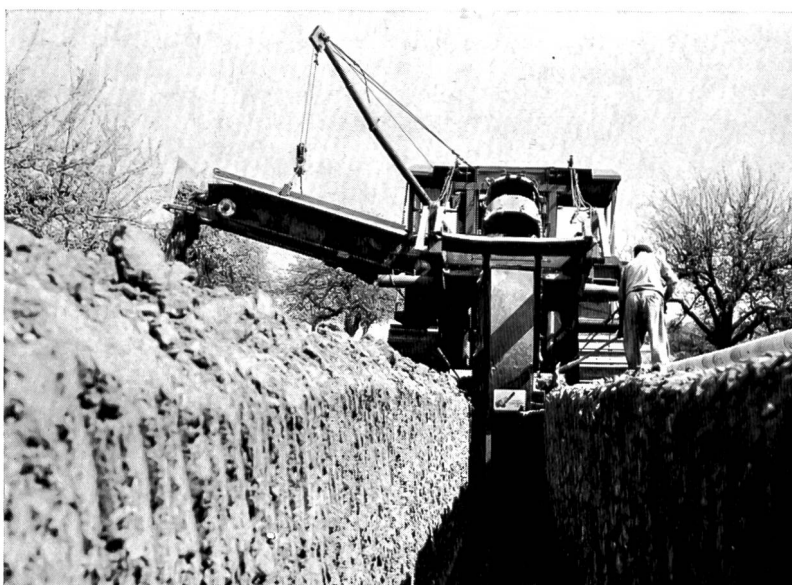
Bilder 2 und 3 Die Grabenfräse an der Arbeit; bei optimalen Verhältnissen beträgt ihre Leistung 180 m/Stunde. Das Aushubmaterial wird über ein Förderband seitlich ausgeworfen.
